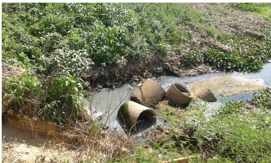
**Figura 105- Tubulação de esgoto danificada, Cáceres-MT. Fonte: Equipe PMD Cáceres, 2017.**
