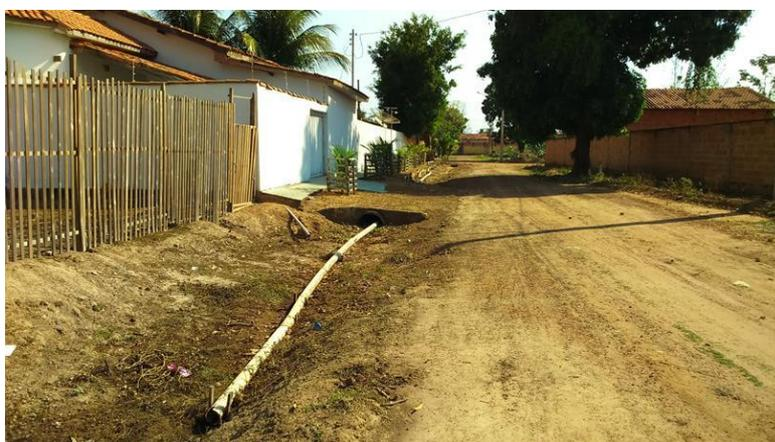
**Figura 79- Lançamento de esgoto a céu aberto. Foto: Flavio A. Crispim (2017).**
