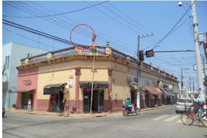
Figura 49: Fachada no comércio central, em Cáceres/MT. Fonte: Acervo pessoal, 2017.
