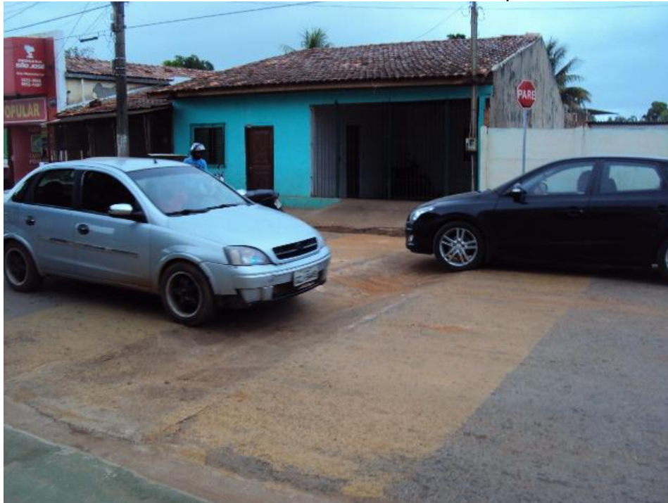
Figura 3.80 – Lombada invertida construída na rua Joaquim Murinho.
