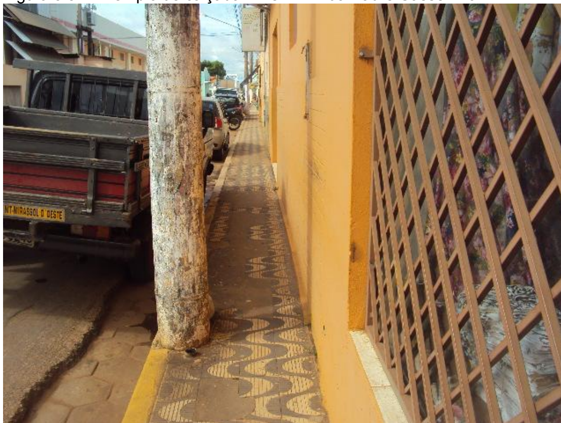
Figura 5.5 – Exemplo de calçada Nível E – Rua Padre Cassemiro.
