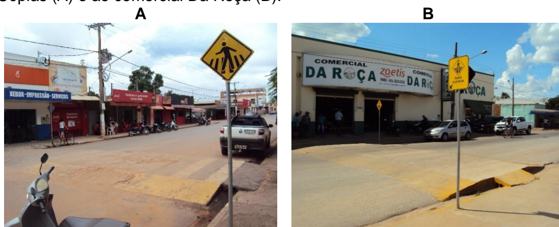
Figura 3.77 – Faixas elevadas para travessia de pedestres em frente ao DCE Cópias (A) e ao comercial Da Roça (B).
