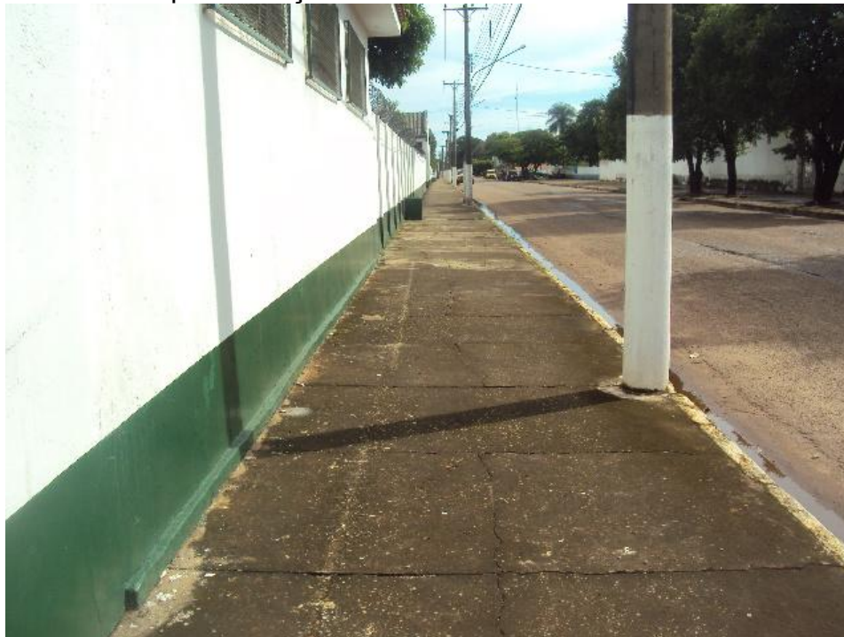
Figura 5.2 – Exemplo de calçada Nível B – Rua Marechal Castelo Branco.
