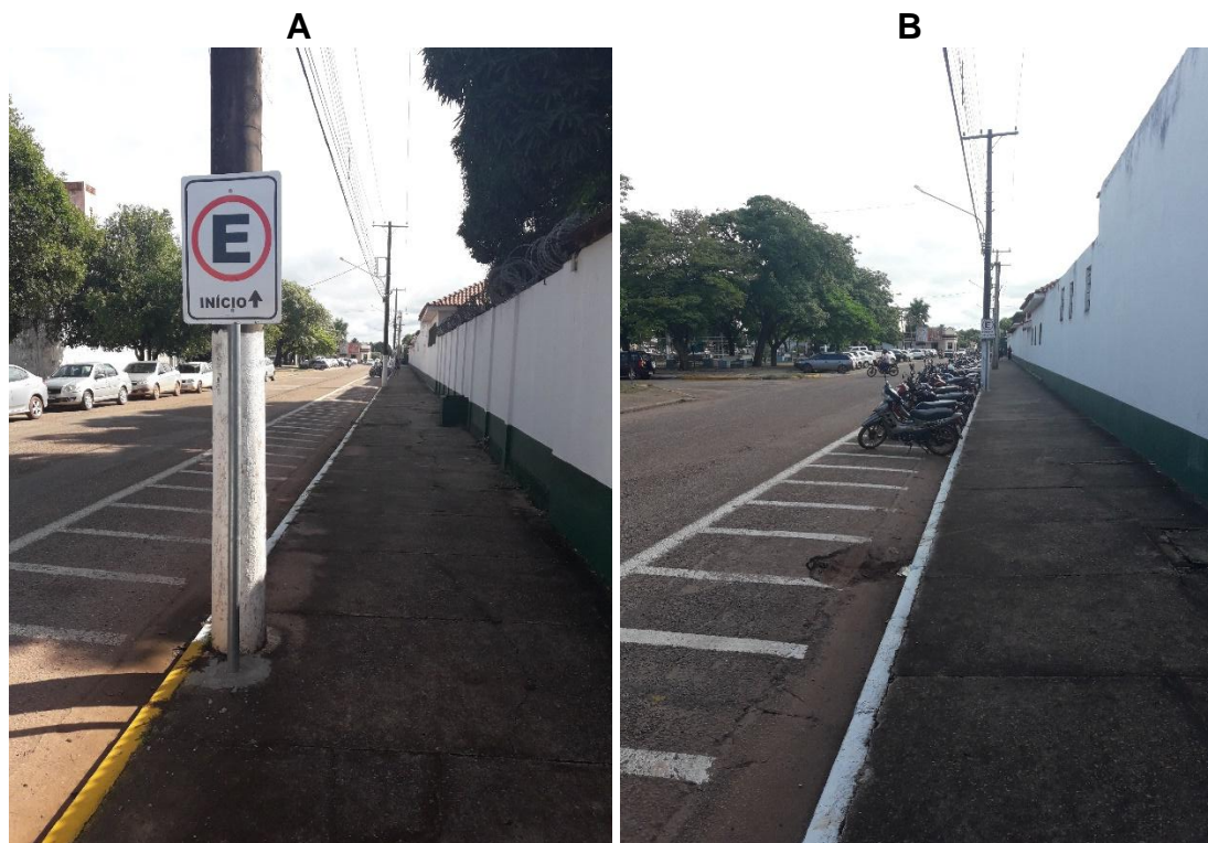
Figura 11.2 – Sinalizações vertical e horizontal para estacionamento de motocicletas na avenida Marechal Castelo Branco.
