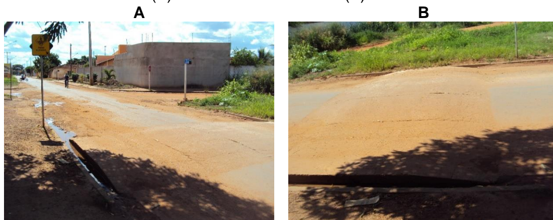
Figura 3.75 – Faixa elevada para travessia de pedestres na rua das Graúnas sentido Centro/bairro (A) e sentido bairro/Centro (B).
