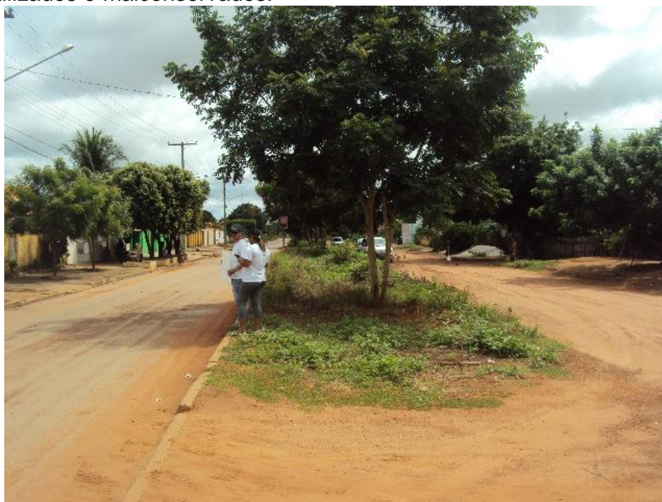
Figura 3.68 – Avenida Europa ou dos Ramieres: canteiro central e pista direita subutilizados e malconservados.
