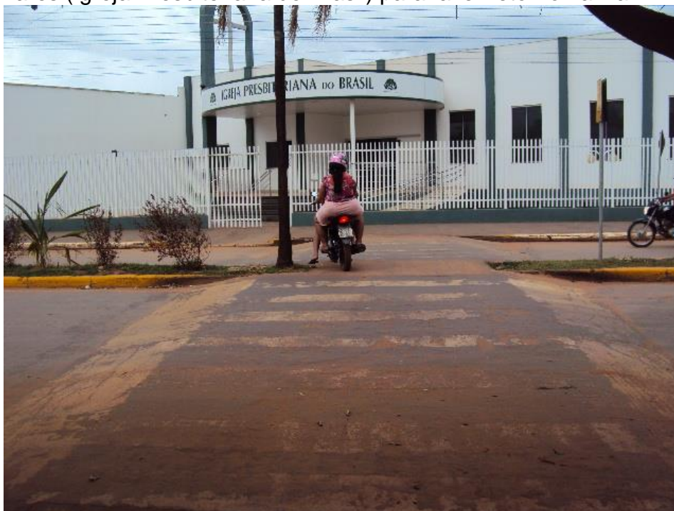
Figura 3.34 – Motociclista utilizando a faixa elevada para pedestres da rua dos Talhamares (Igreja Presbiteriana do Brasil) para fazer retorno na via.
