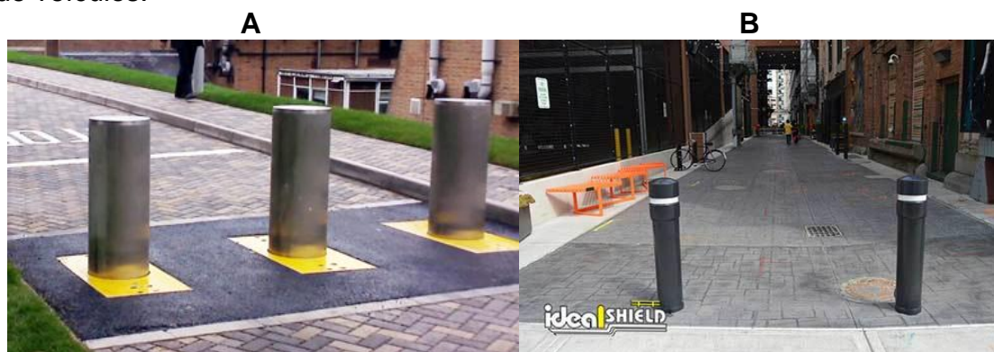
Figura 8.5 – Modelos de barreiras móveis (“bollards”) para restrição de tráfego de veículos.
