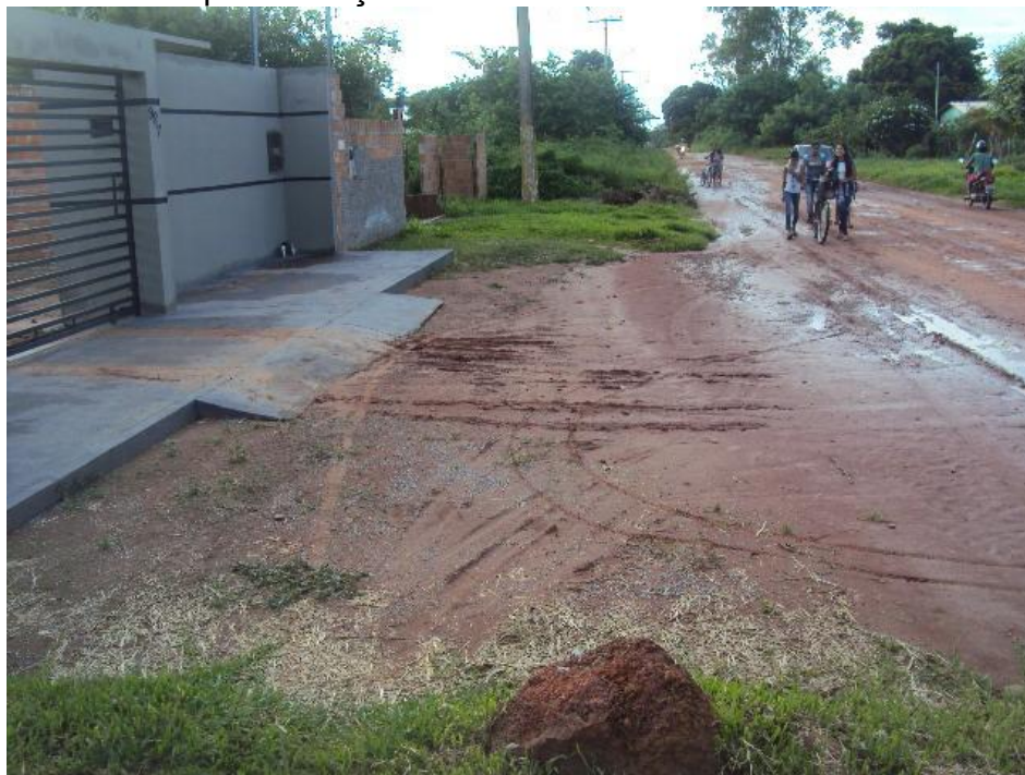
Figura 5.6 – Exemplo de calçada Nível E – Via dos Bandeirantes.
