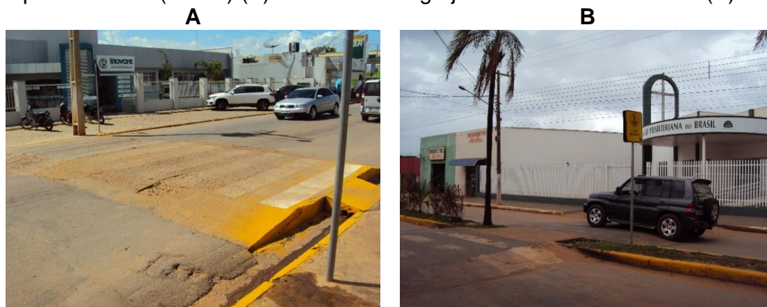
Figura 3.76 – Faixas elevadas para travessia de pedestres em frente ao Juba Supermercados (Jubão) (A) e em frente à Igreja Presbiteriana do Brasil (B).
