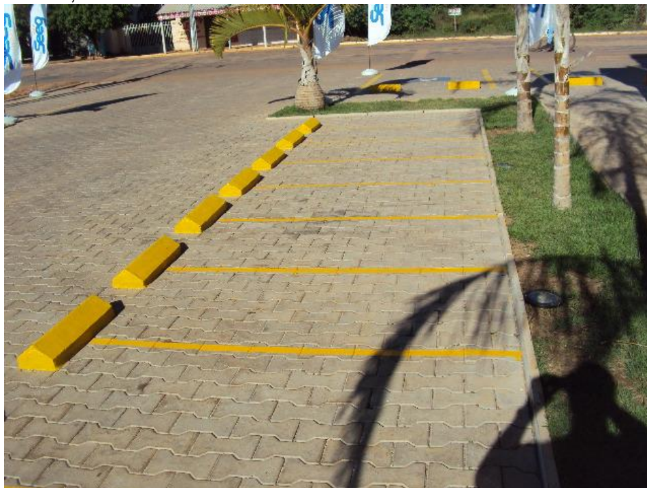
Figura 11.5 – Exemplo de sinalização horizontal para estacionamento de motocicletas, com barreira física.
